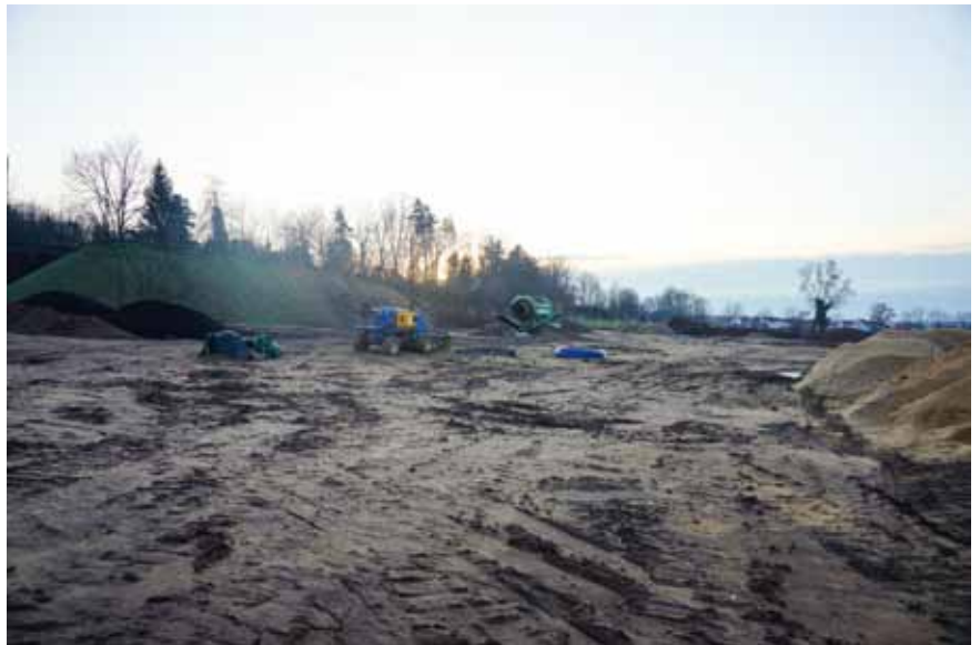
Neubau des D-Platzes im Hans-Reif-Sportzentrums
